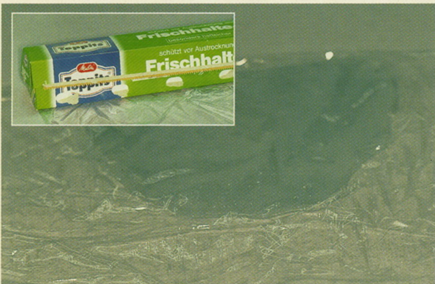
Abb. 4 Abdeckung des noch unpolymersierten Kunststoffes zur Isolierung mittels besonders dünner Polyäthylenfolie
